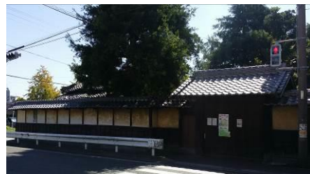
▲国道500号沿いに残る冠木門と瓦塀
