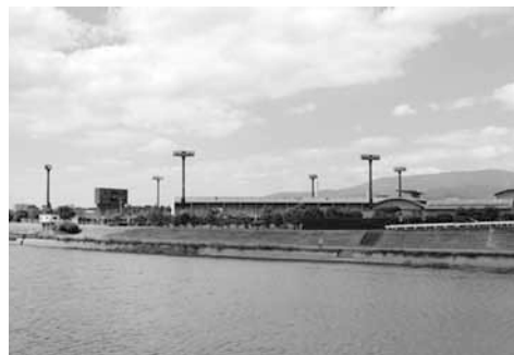
▲ 小郡市野球場の遠景
