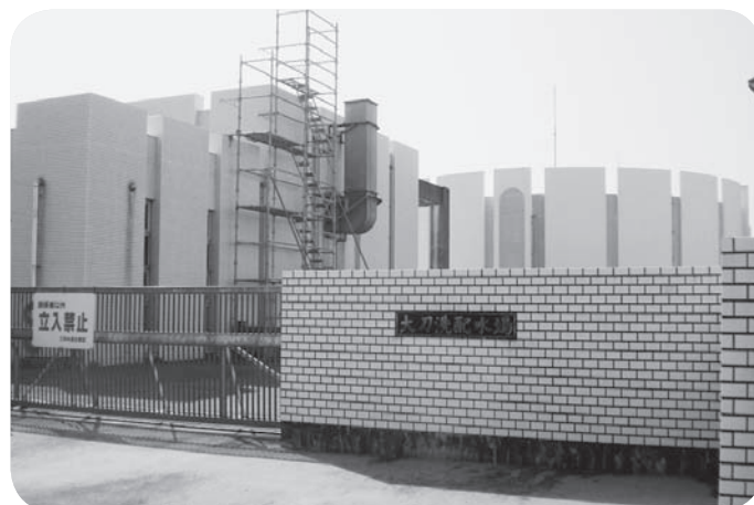
▲三井水道企業団 大刀洗配水場
