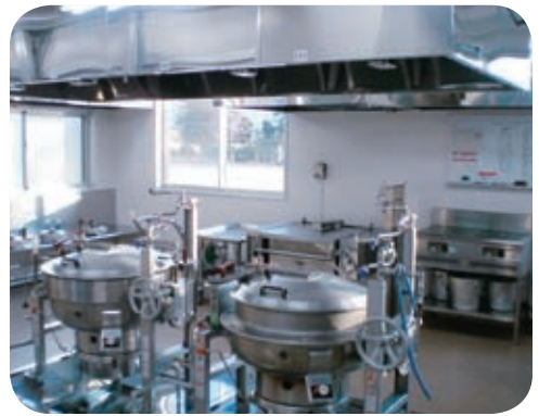
▲御原小学校給食調理室
