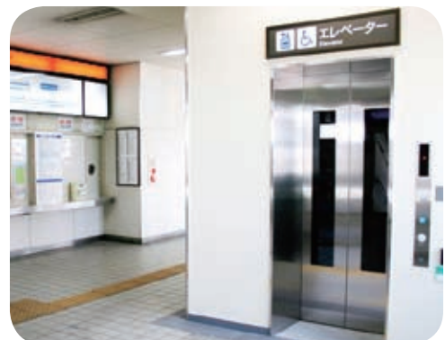
▲西鉄小郡駅エレベーター
