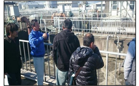
〈役員視察・佐賀市下水浄化センター〉
