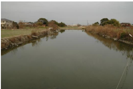
止水部。複断面の泥底の浅場がある左の環境と、右の護岸では浄化能力、底生動物の生息状況が異なる。集落周辺でブロック積みを用いる場合は、多用しすぎないことが重要である。
