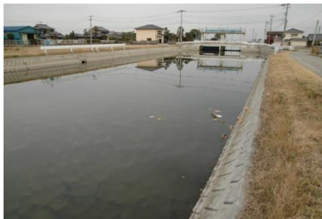
止水部。複断面の泥底の浅場がある左の環境と、右の護岸では浄化能力、底生動物の生息状況が異なる。集落周辺でブロック積みを用いる場合は、多用しすぎないことが重要である。
