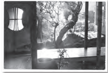
新発見の透かし窓のはいったそで壁(左端)
