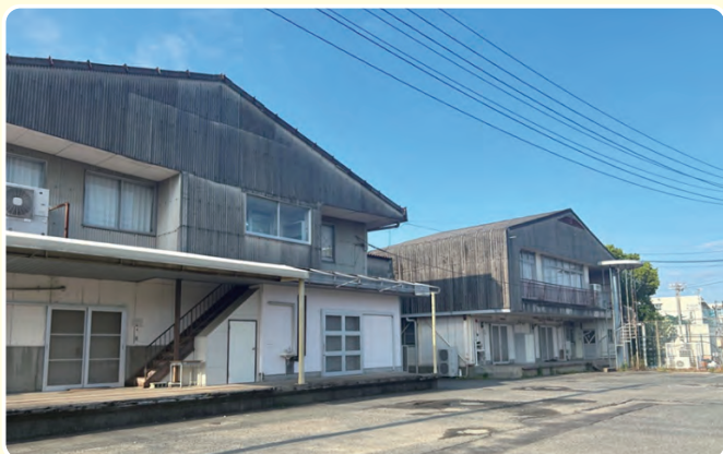
解体前の旧学校給食センター（令和8年6月撮影）
