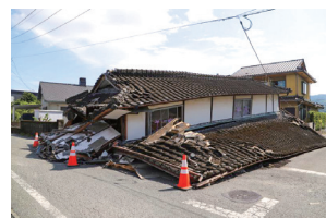
宇土市の被災状況
