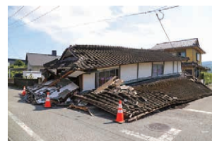
宇土市の被災状況
