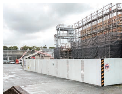
建て替え中の三井消防署
