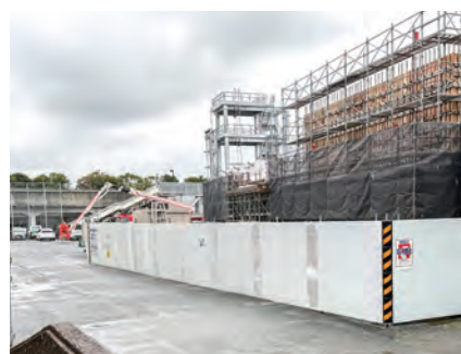
建て替え中の三井消防署
