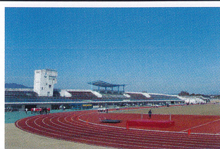
小郡市陸上競技場
