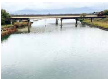
甘木鉄道の橋脚
