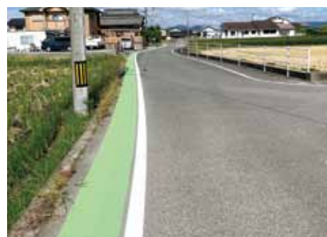
グリーンベルトと外柵で安全を確保
