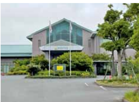
災害備蓄品を備えたあすてらす
