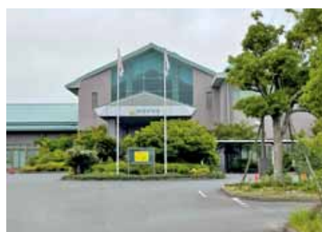
災害備蓄品を備えたあすてらす
