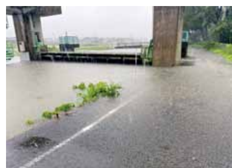
R 3年8月豪雨の際の築地川、越水の様子
