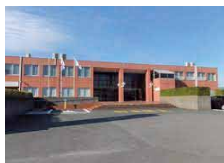
小郡市現体育館
