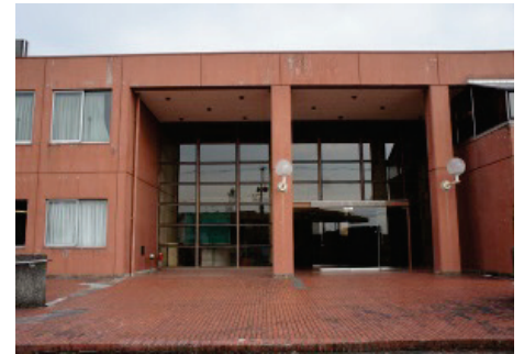
図 3-2 体育館入口正面
