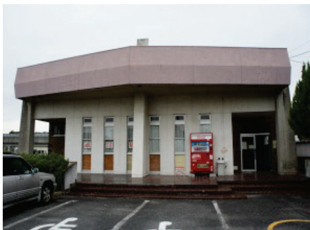
図 3-6 武道場入口全景
