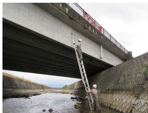
橋の点検状況 (橋の側面を点検している状況です。)
