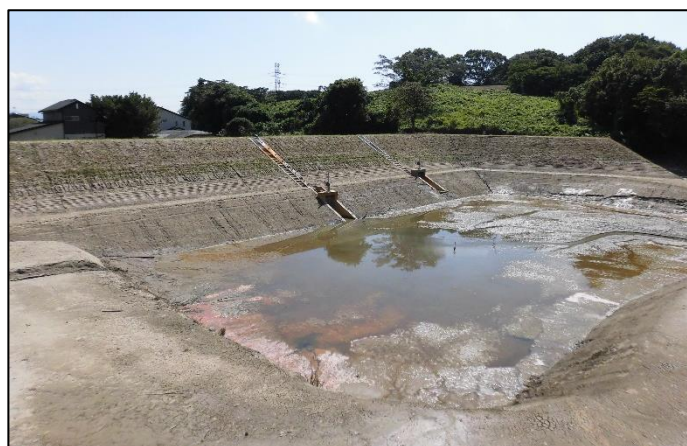
【影堤：堤体・波受ブロック・取水施設・洪水吐】
