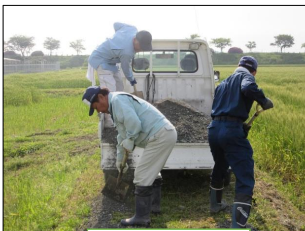
【農地維持:道路補修】
