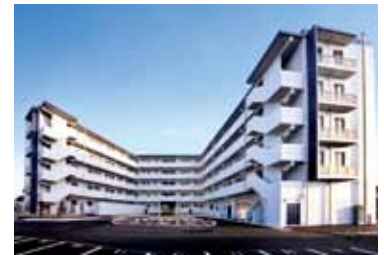
▲市営住宅建設事業
