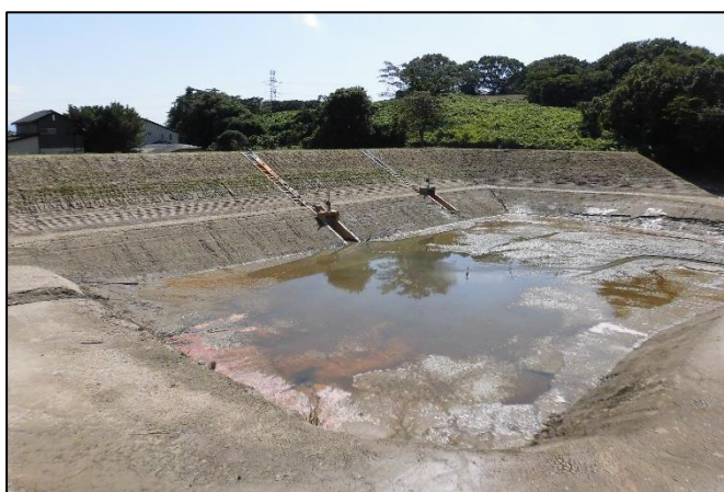
【影堤：堤体・波受ブロック・取水施設・洪水吐】
