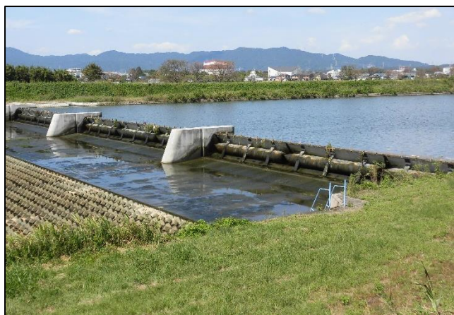
【影堤：堤体・波受ブロック・取水施設・洪水吐】
