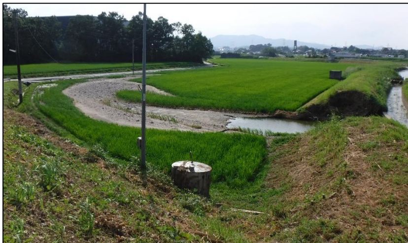
○令和元年7月豪雨災害
