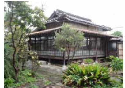
平田家住宅 (市有形：建造物)
