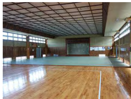
図 2-9 武道場室内の現況
