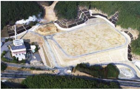
▲整地された新施設用地（左：現焼却施設）
