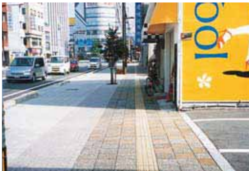
▲接続部の勾配が緩和された歩道（今治市）
