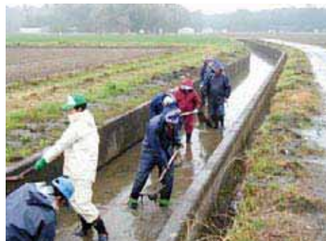
▲水路の泥上げ
