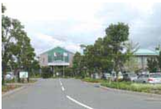
小郡市総合保健福祉センター「あすてらす」
