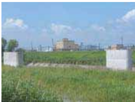
宝満川左岸より（橋却部分）
