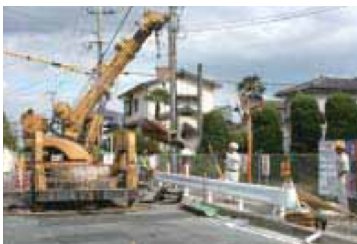
下水道工事（宝城団地内）
