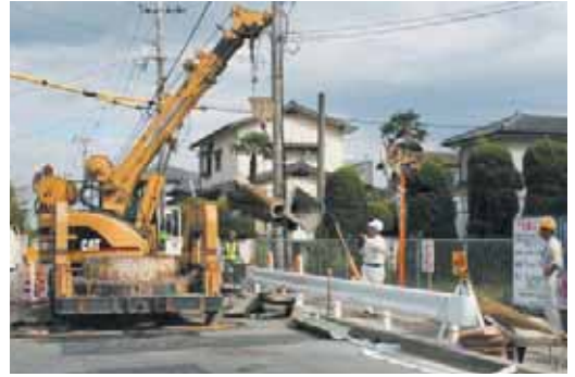
下水道工事（宝城南区）
