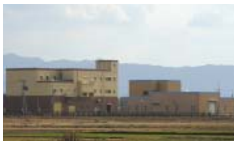
福童浄化センター (左:汚泥処理棟、右:ポンプ棟)
