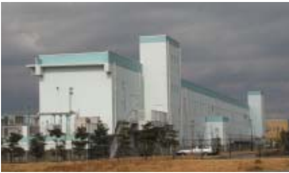
福童浄化センター(水処理施設)
