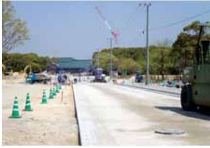
▲九州歴史資料館関連の下水道整備後、現在道路整備中
