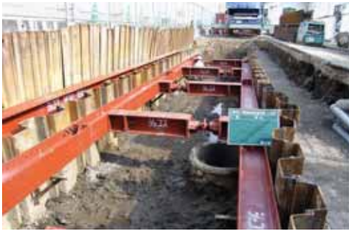
▲大原地区排水路整備工事
