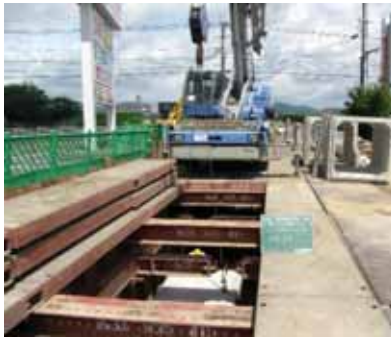
▲大原地区排水路工事
