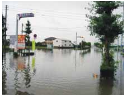
▲冠水した七夕神社西交差点付近
