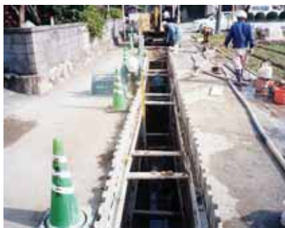
▲下水道工事風景
