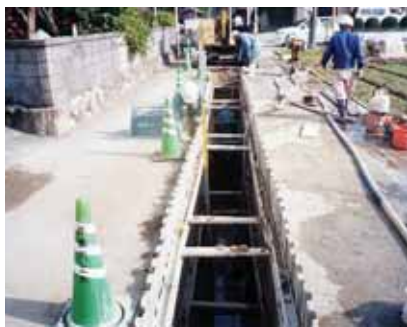
▲下水道工事風景
