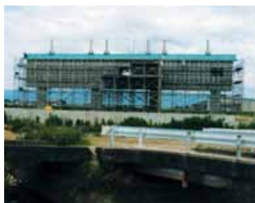
▲宝満川・築地川樋門工事現場(端間橋上流部)
