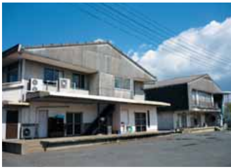
▲小郡市立給食センター
