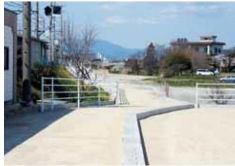
▲端間駅東側の歩道整備
