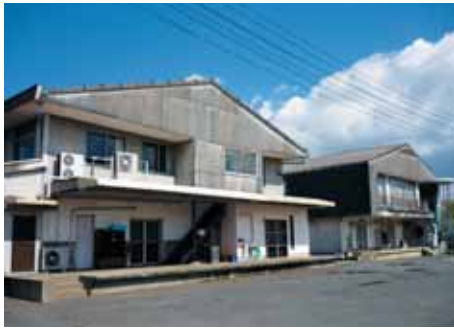
▲小郡市立給食センター
