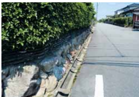
▲宝城団地内道路側溝
