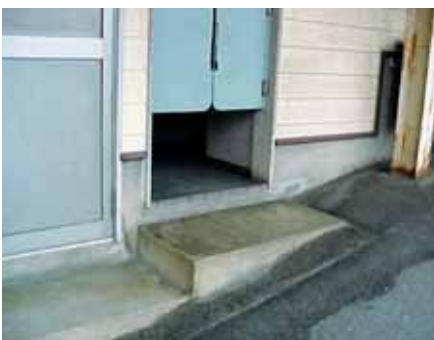
▲段差のある駅トイレの出入口
