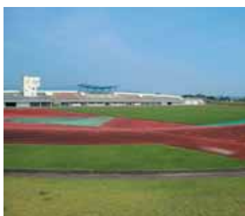
▲小郡市陸上競技場
