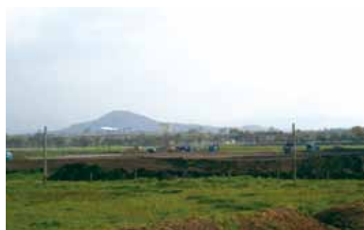
▲イオン建設予定地造成中(大保)
