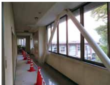
▲庁舎の耐震工事
