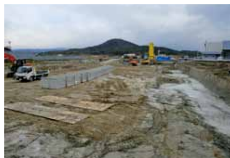
▲造成工事中の干潟第2工業団地
