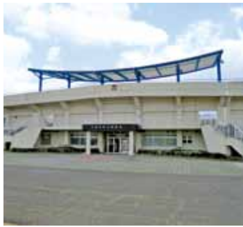
▲小郡市陸上競技場
