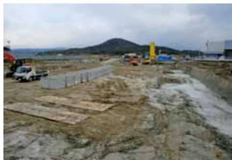
▲造成工事中の干潟第2工業団地
