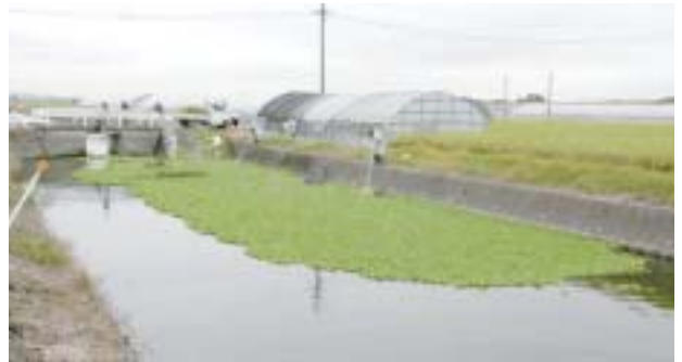
▲上西区水路での除去作業
