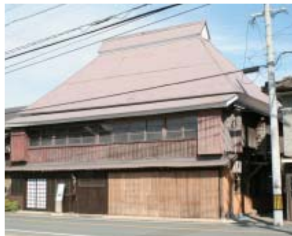
▲改修後の油屋
