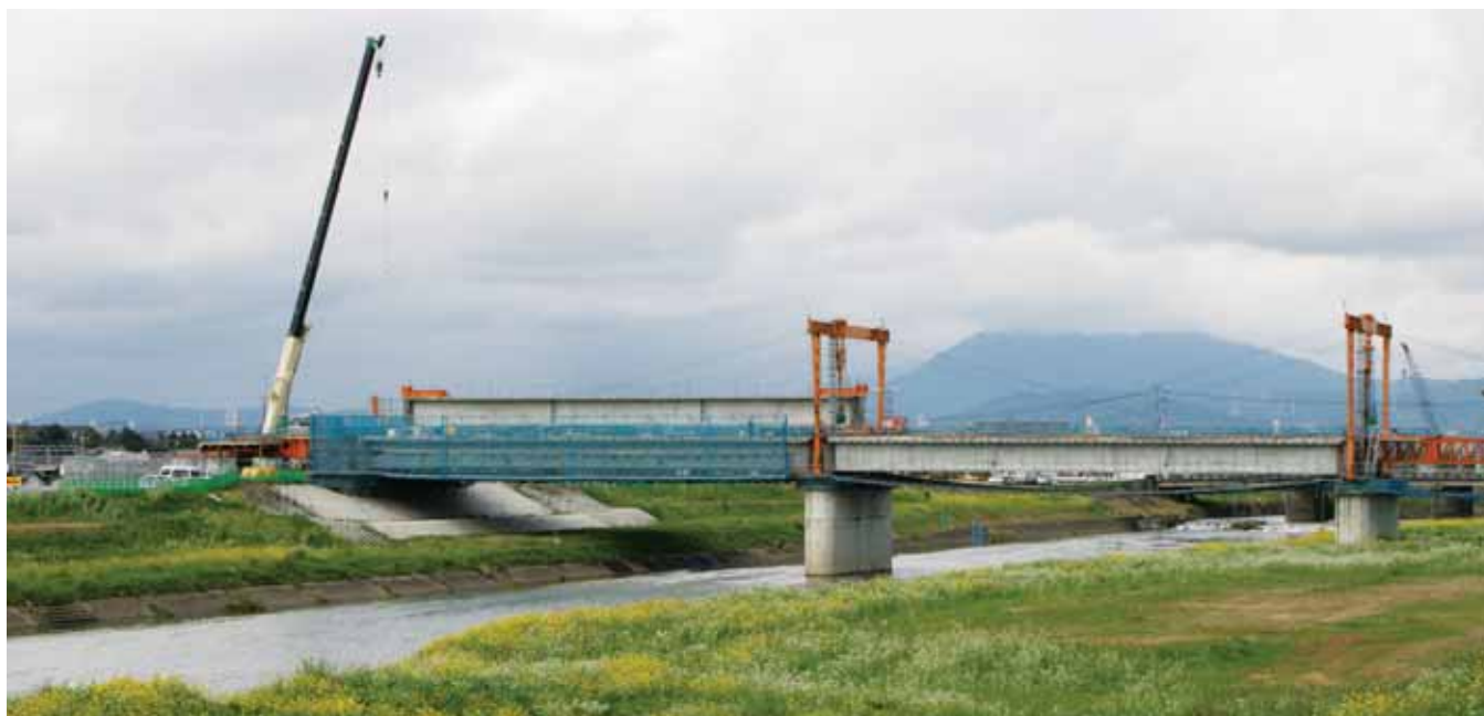
◀ 工事が進む県道鳥栖朝倉線架橋工事(端間橋下流)
